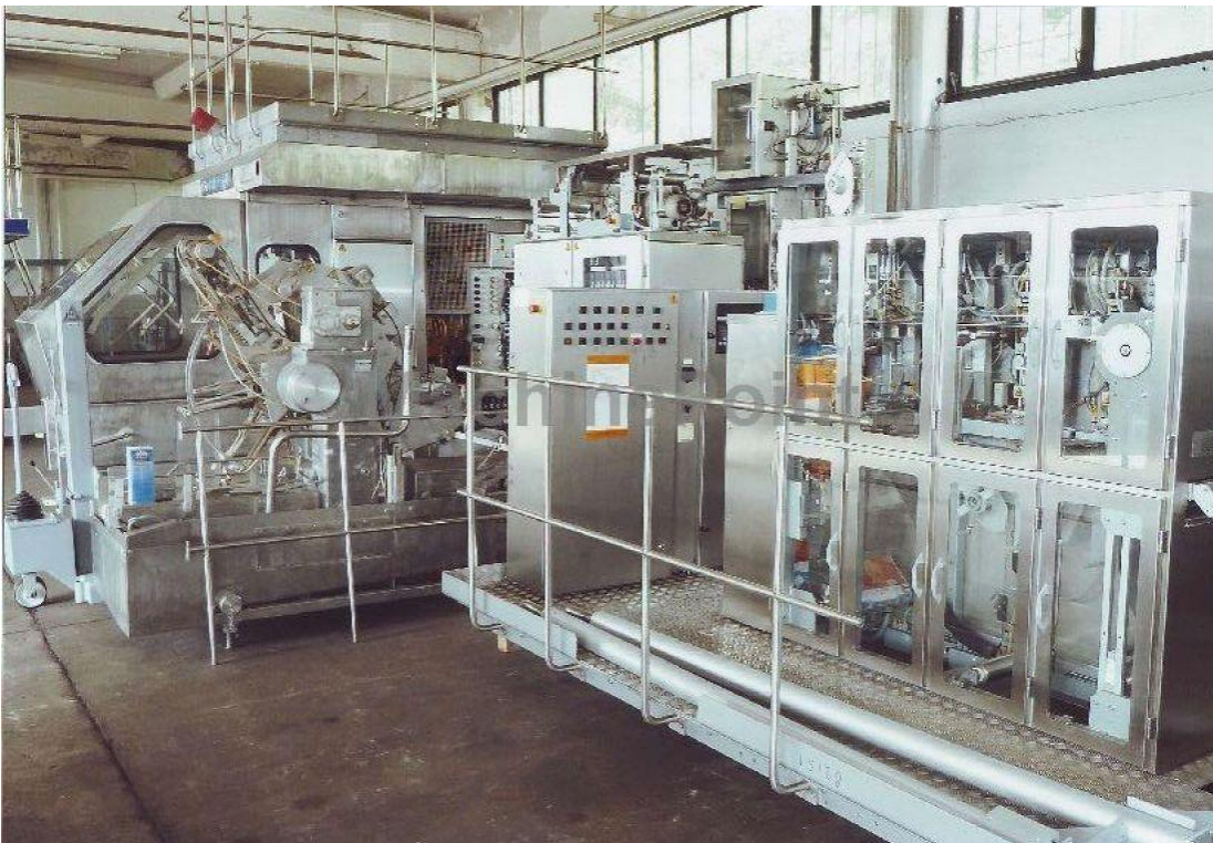
Abb. 21: Aktuelle Klimaanlage der Produktionsabteilung
